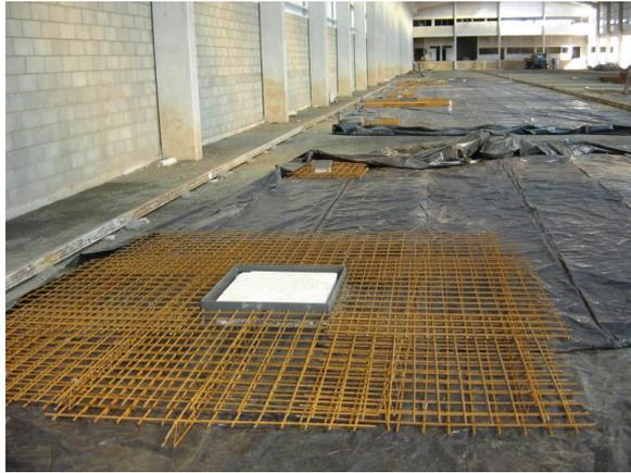
Fotografia 24 – Reforço do piso na região de caixas de passagem (Fonte: Própria)
