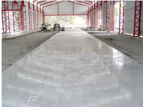
Fotografia 36 – Faixa de concretagem prestes a ser submetida aos cortes nas juntas serradas –
