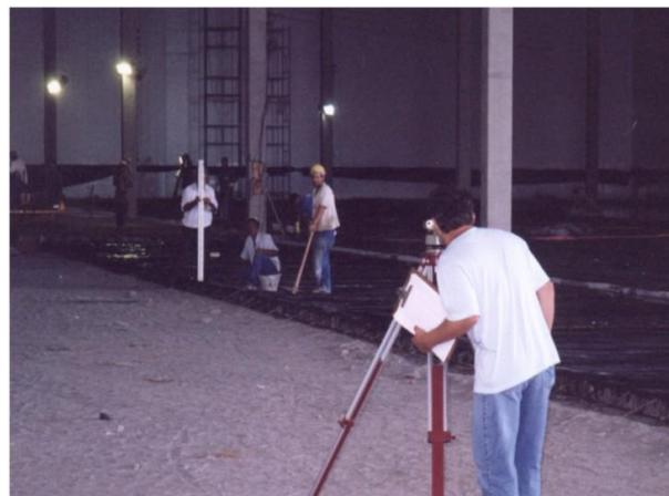
Fotografia 15 – Nivelamento das formas com teodolito (Fonte: Própria)
