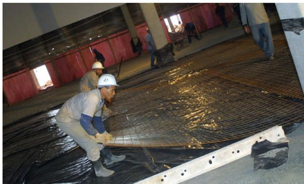
Fotografia 17 – Posicionamento das telas soldadas inferiores (Fonte: Própria)
