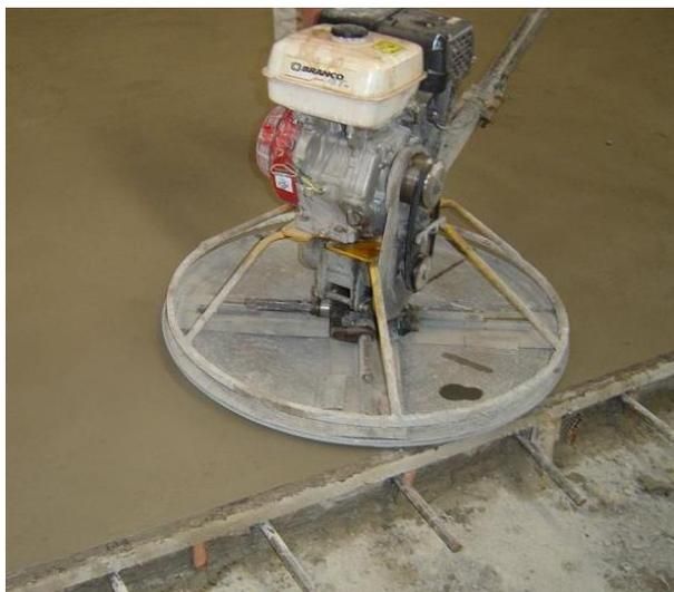
Fotografia 33 – Flotador mecânico (Fonte: Própria)
