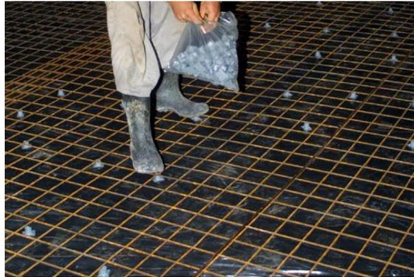
Fotografia 18 – Colocação do espaçador plástico (Fonte: Própria)
