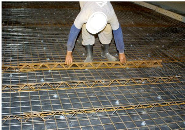
Fotografia 25 – Colocação do espaçador treliçado (Fonte: Própria)
