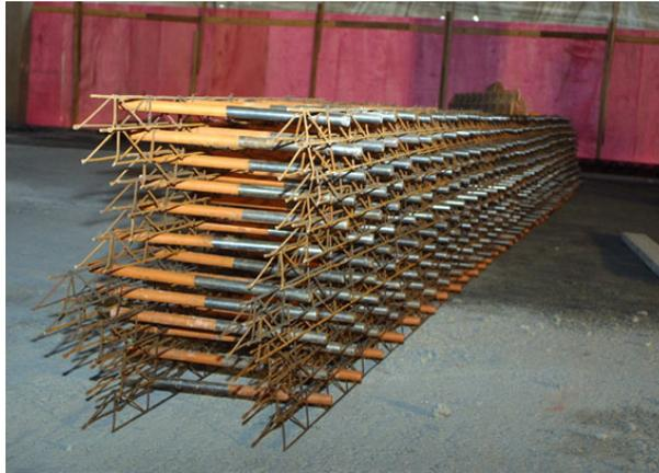
Fotografia 20 – Barras de transferência da junta serrada (Fonte: Própria)
