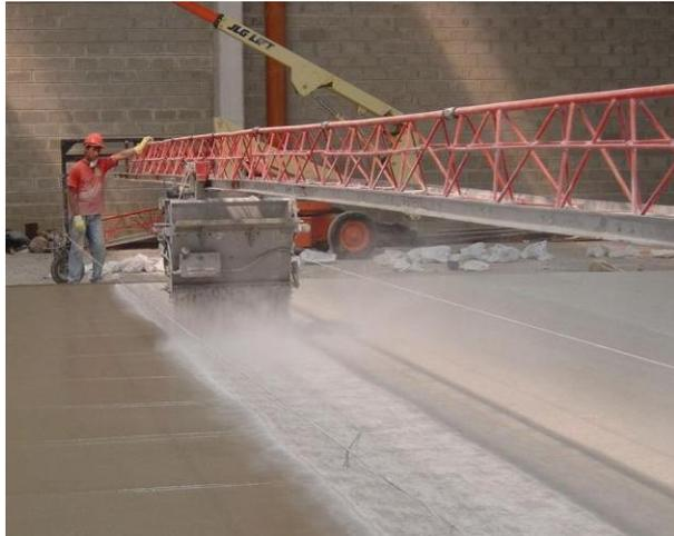
Fotografia 32 – Aspersão mecanizada de agregado mineral (Fonte: Própria)
