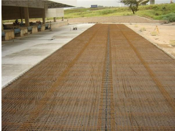
Fotografia 26 – Armadura pronta para concretagem (Fonte: Própria)
