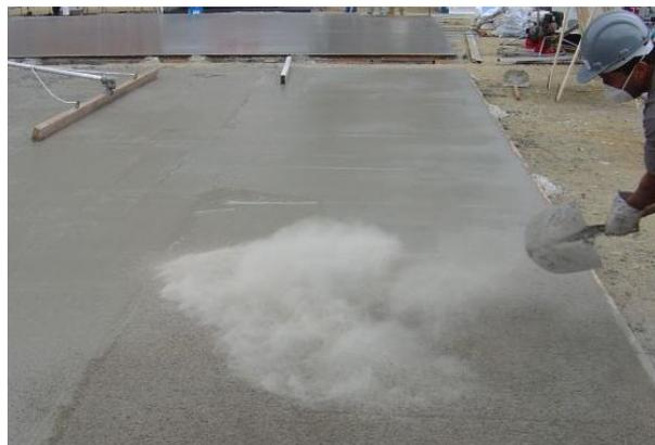
Fotografia 31– Aspersão manual de agregado mineral (Fonte: Própria)
