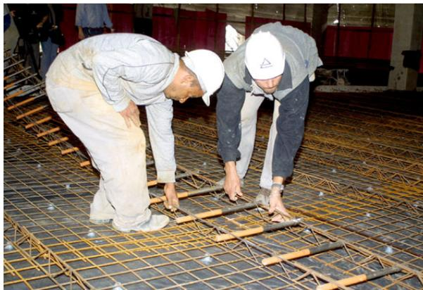
Fotografia 21 – Posicionamento das barras de transferência (Fonte: Própria)
