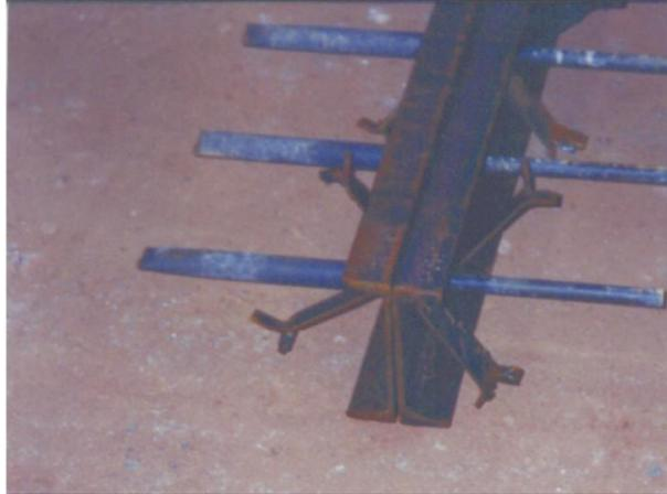
Fotografia 22 – Barras de transferência na junta construtiva (Fonte: Própria)
