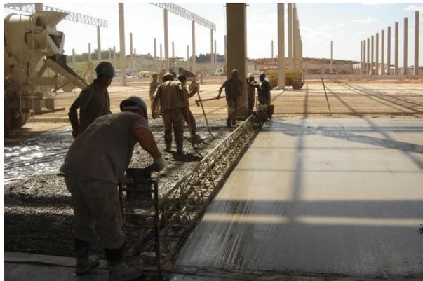
Fotografia 27 – Concretagem com régua vibratória (Fonte: Própria)
