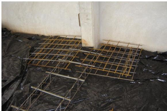
Fotografia 23 – Reforço do piso na região de cantos dos pilares (Fonte: Própria)
