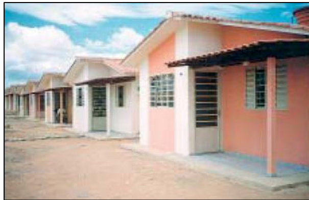
Fotografia 27 - Unidades concluídas - Fonte: (ABCP, 2002)
