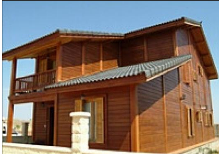
Fotografia 36 – Casa construída no sistema log – Fonte: (MEIRELLES, et al, 2008, p.3).
