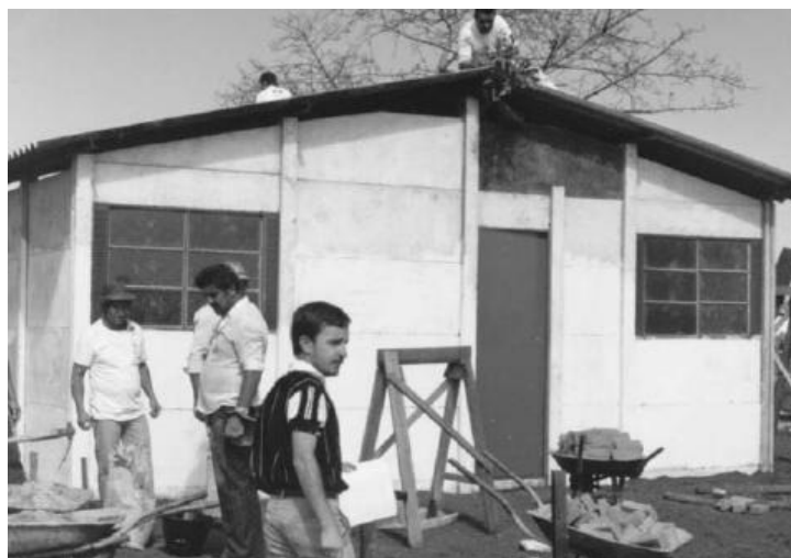
Fotografia 34 - Casa concluída as 15 hs – Fonte: (FREITAS, 2007)
