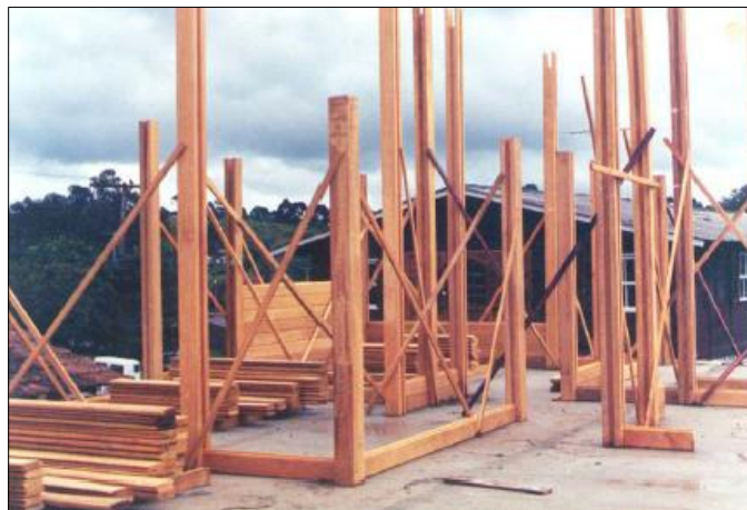
Fotografia 37 - Prumagem das colunas por meio de contraventamento – Fonte: (LAROCA, 2002, P.32).
