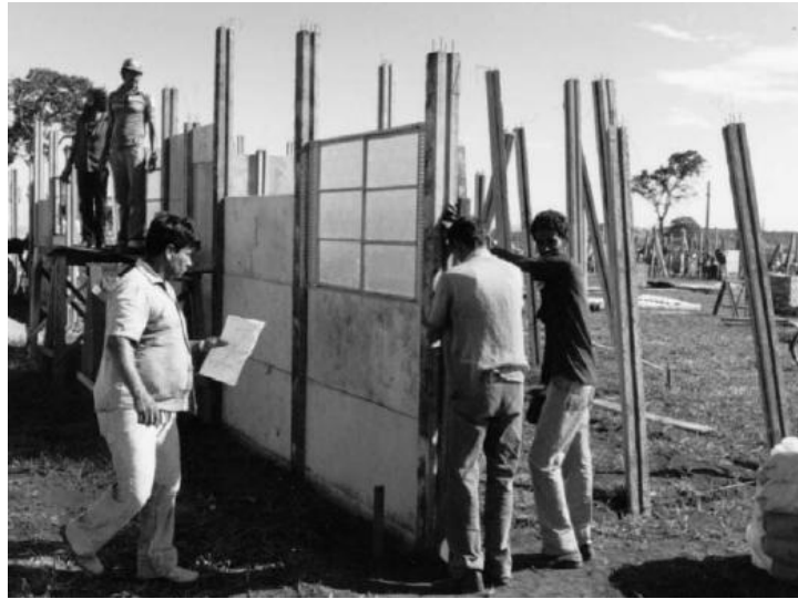
Fotografia 30 - Tomada de prumo as 10 hs – Fonte: (FREITAS, 2007)
