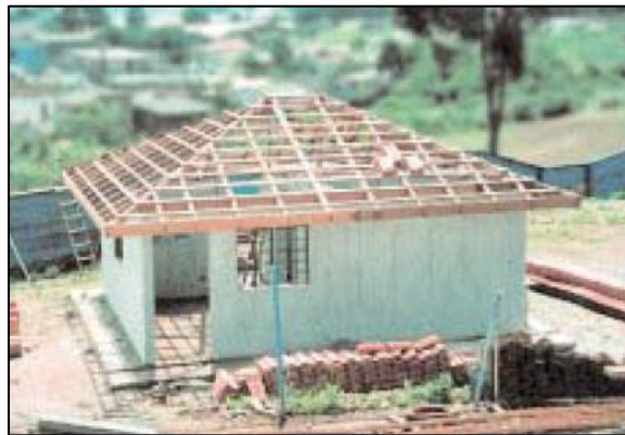
Fotografia 24 - Telhado de madeira ou metálico - Fonte: (ABCP, 2002)
