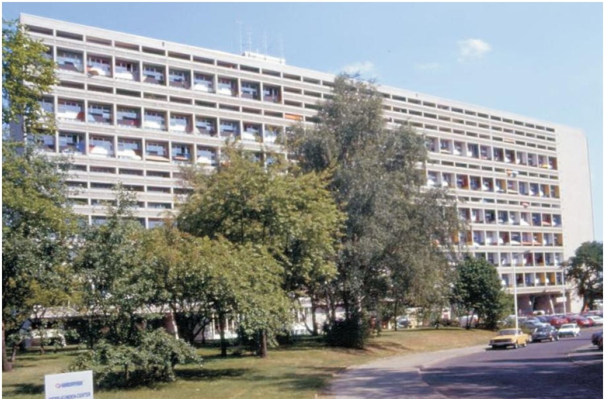
Fotografia 5 - Edifício Le Corbusier – Marselha – Fonte: (SOUZA, et al, 2008, p.5)
