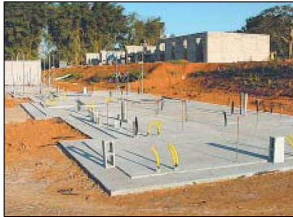
Fotografia 17 - Fundação em radier - Fonte: (ABCP, 2002)
