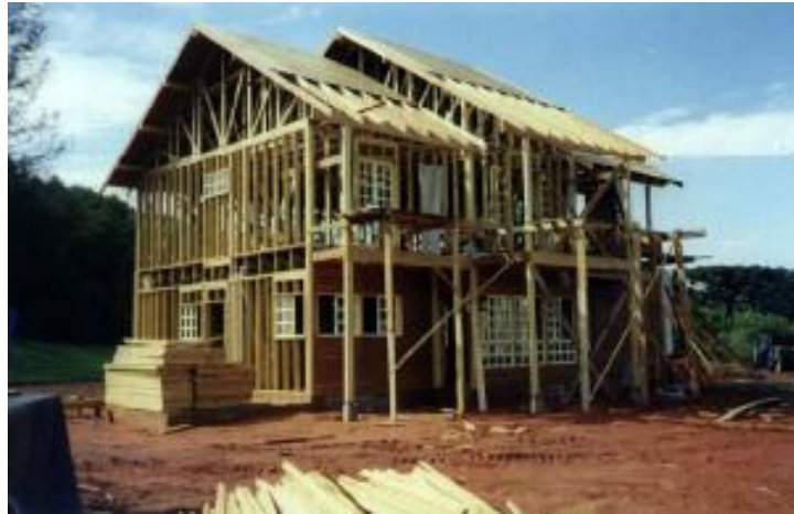
Fotografia 40 - Sistema tipo plataforma – Fonte: (LAROCA, 2002, P.34)
