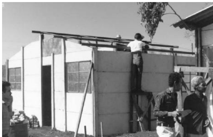
Fotografia 33 - Montagem da estrutura metálica para apoio das telhas – Fonte: (FREITAS, 2007)
