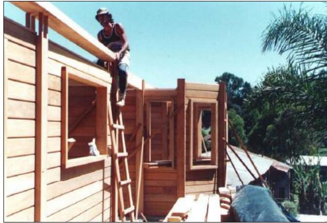
Fotografia 38 - Colocação das pranchas de vedação – Fonte: (LAROCA, 2002, P.32).
