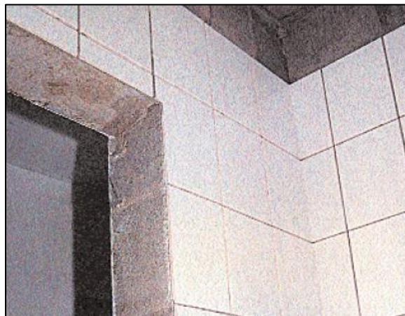
Fotografia 23 - Revestimento cerâmico aplicado direto no bloco - Fonte: (ABCP, 2002)
