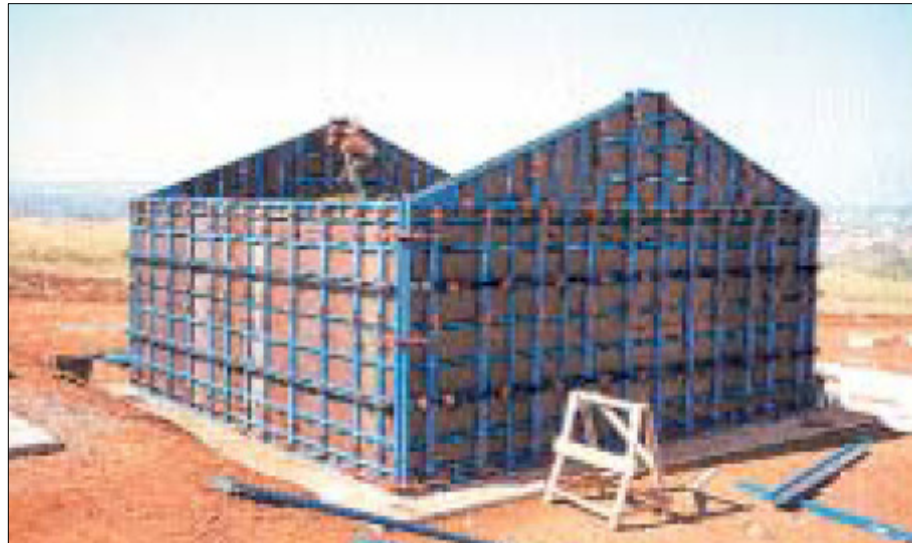
Fotografia 44 – Mostram o posicionamento das formas internas e externas afastadas entre si na distancia correspondente a espessura da parede – Fonte: (ABCP, 2002)
