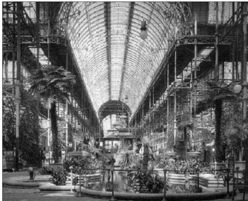
Fotografia 3 – Palácio de cristal – vista interna – Fonte: (LACERDA, 2005, p.26)
