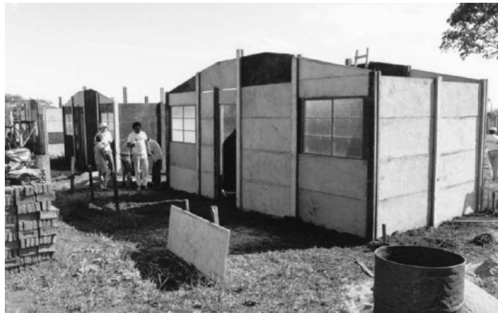
Fotografia 32 - Montagem dos elementos pré-fabricados concluídos as 12 hs – Fonte: (FREITAS, 2007)
