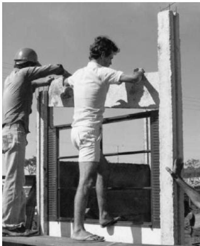
Fotografia 31 - Colocação das janelas e vergas as 11 hs – Fonte: (FREITAS, 2007)
