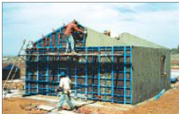
Fotografia 49 – Desforma após 12 horas da concretagem
