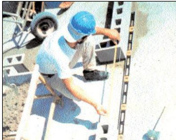
Fotografia 19 - Assentamento da 1ª fiada - Fonte: (ABCP, 2002)
