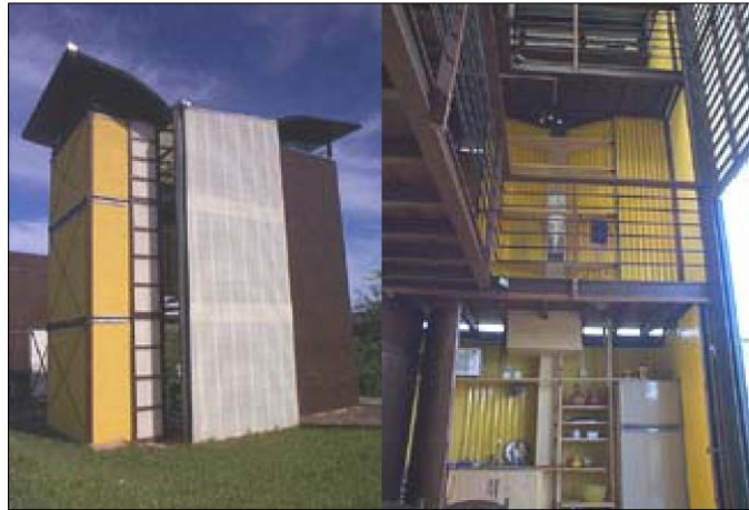
Fotografia 42 - Unidade habitacional em madeira – Fonte: (LAROCA, 2002, P.17)
