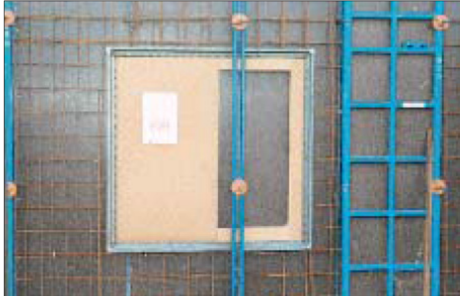
Fotografia 46 – Armaduras em tela soldada utilizada nas paredes e a esquadria posicionada – Fonte: (ABCP, 2002)
