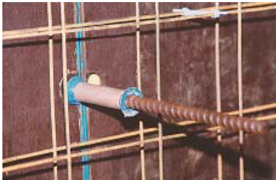
Fotografia 45 – Apresenta o dispositivo que assegura o distanciamento correto entre as duas formas – Fonte: (ABCP, 2002)
