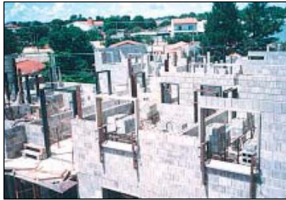
Fotografia 20 - Contramarcos pré-fabricados - Fonte: (ABCP, 2002)
