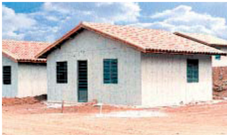
Fotografia 43 – Casa em concreto celular finalizada – Fonte: (ABCP, 2002)
