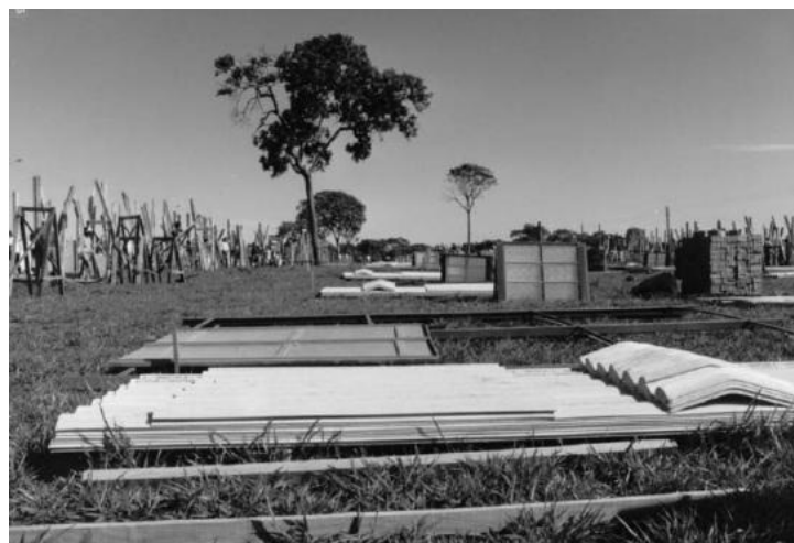
Fotografia 29 - Estocagem dos materiais - preparo para a montagem – Fonte: (FREITAS, 2007)
