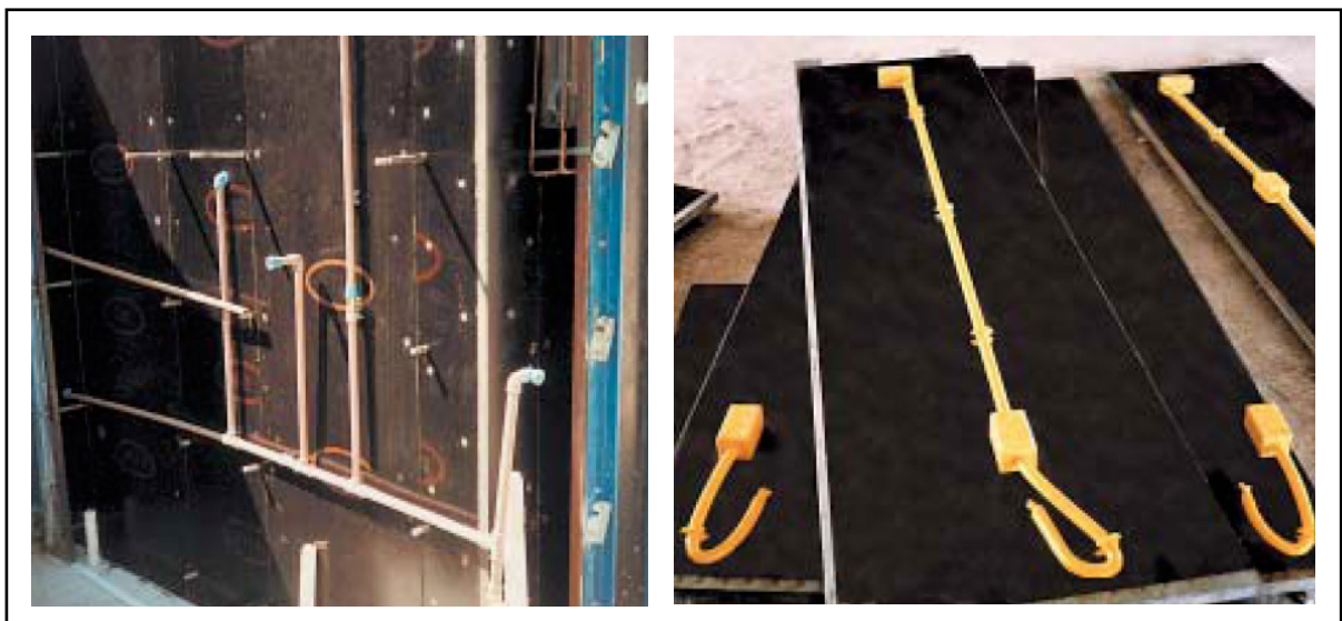
Fotografia 47 – Elementos das instalações hidráulicas e elétricas fixadas nas formas – Fonte: (ABCP, 2002)
